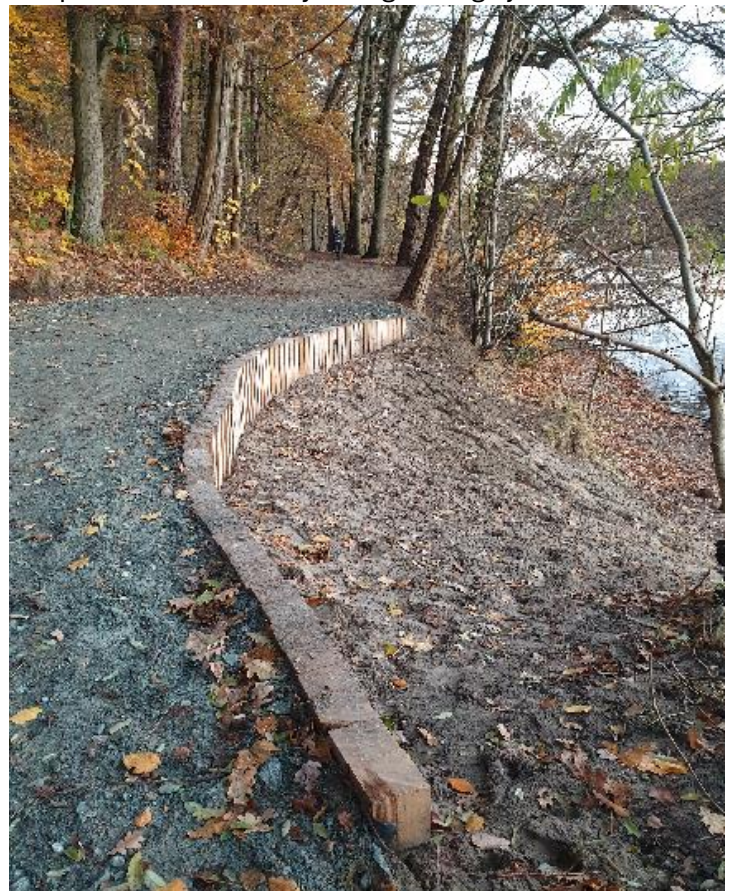
Wzmocniona skarpa i nowa nawierzchnia ścieżki-nad korzeniami drzew zapewniająca bezpieczeństwo spacerów.
