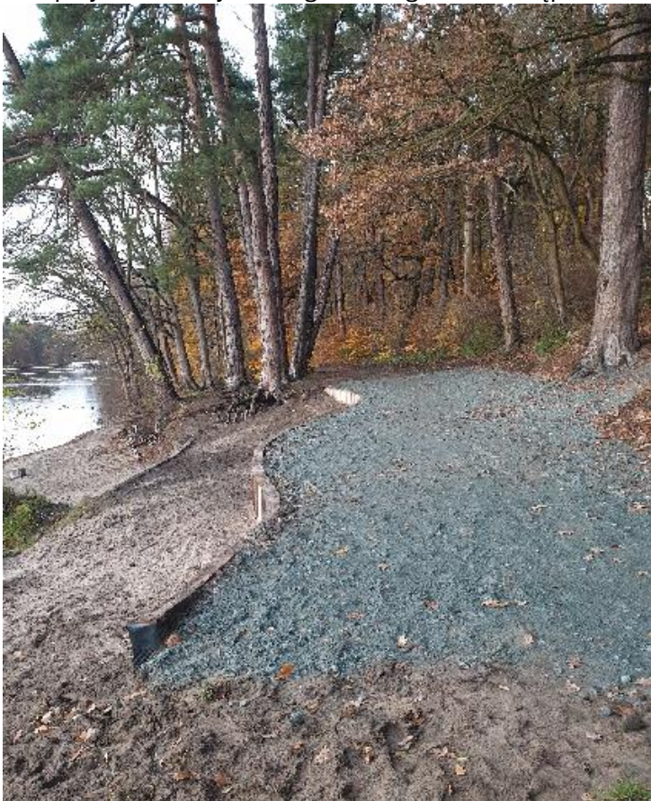
Brzeg po wzmocnieniu dwupoziomową palisadą z twardego drewna, wypoziomowana ścieżka spacerowa.
