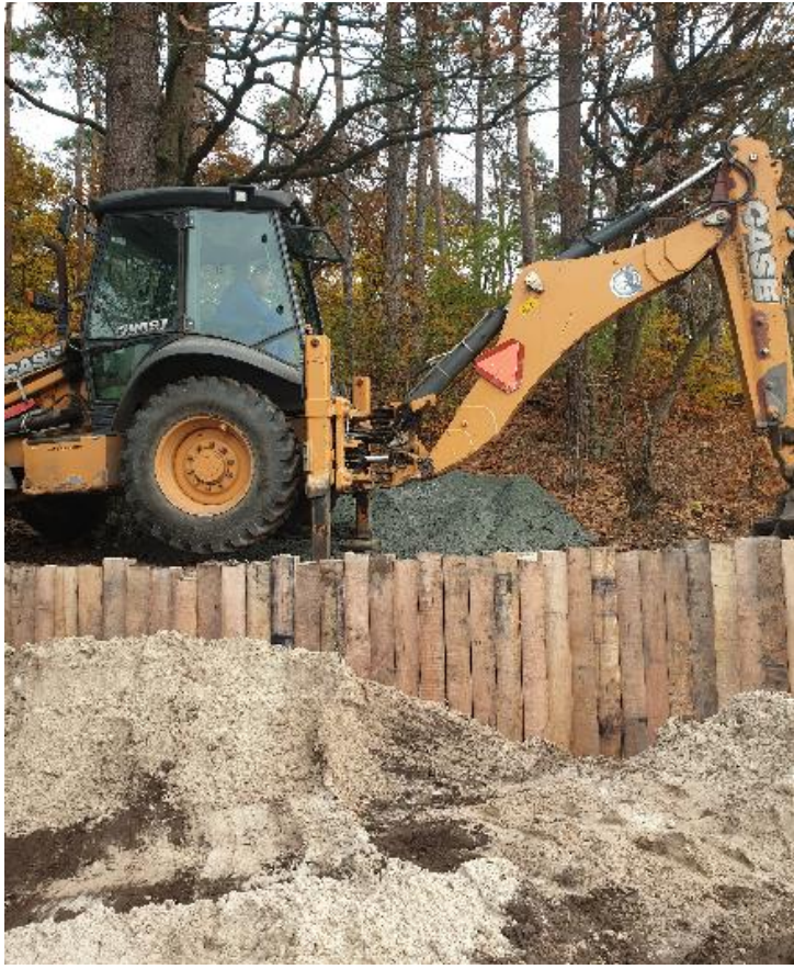
Prace przy zniszczonym brzegu koło ogrodzenia Kąpieliska M.
