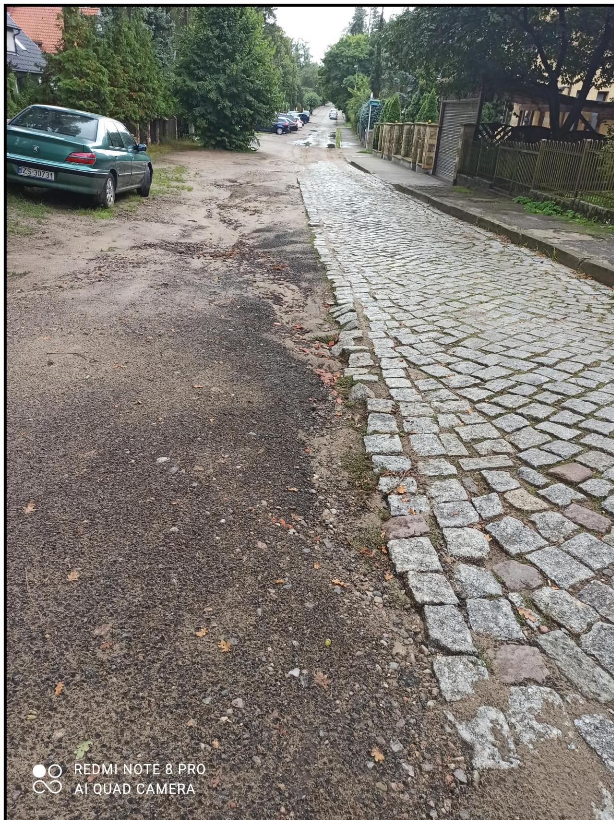
ZDJĘCIE NR 5 – ul.Pogodna na odcinku od ul.Piaszczystej do ul.Orzechowej
