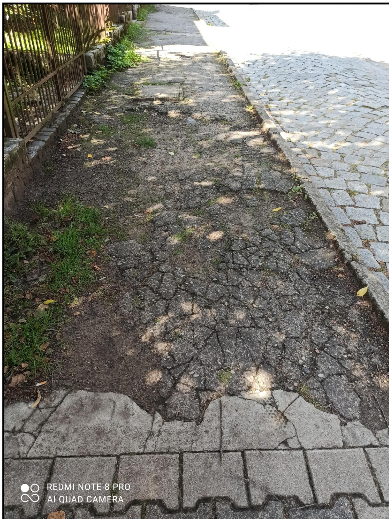
Zdjęcie nr 9 – Istniejący chodnik
