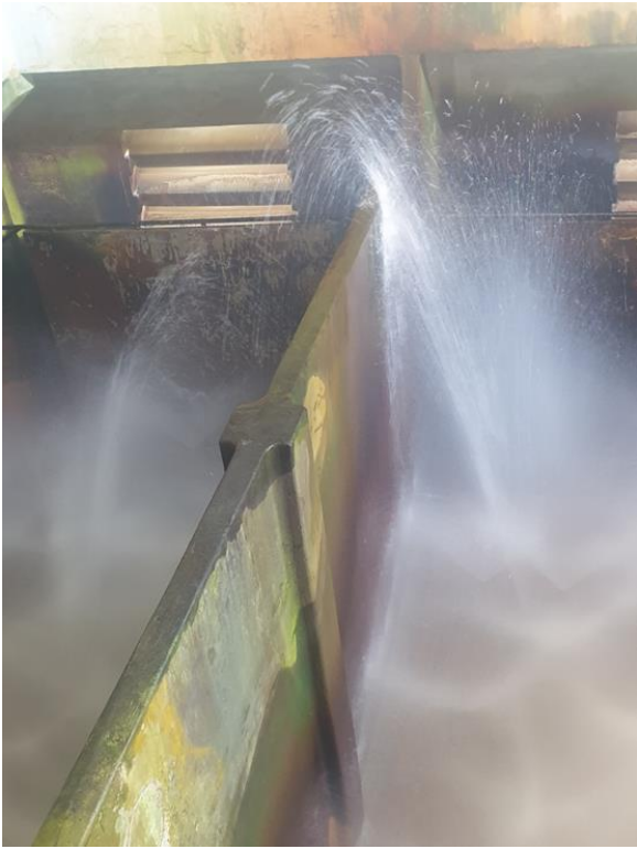
Baseny napowietrzające wodę podawaną z 12 studni głębinowych pilchowskiego ujęcia – ze 100m pod ziemią, każda studnia podaje ok. 100m 3 /h.
