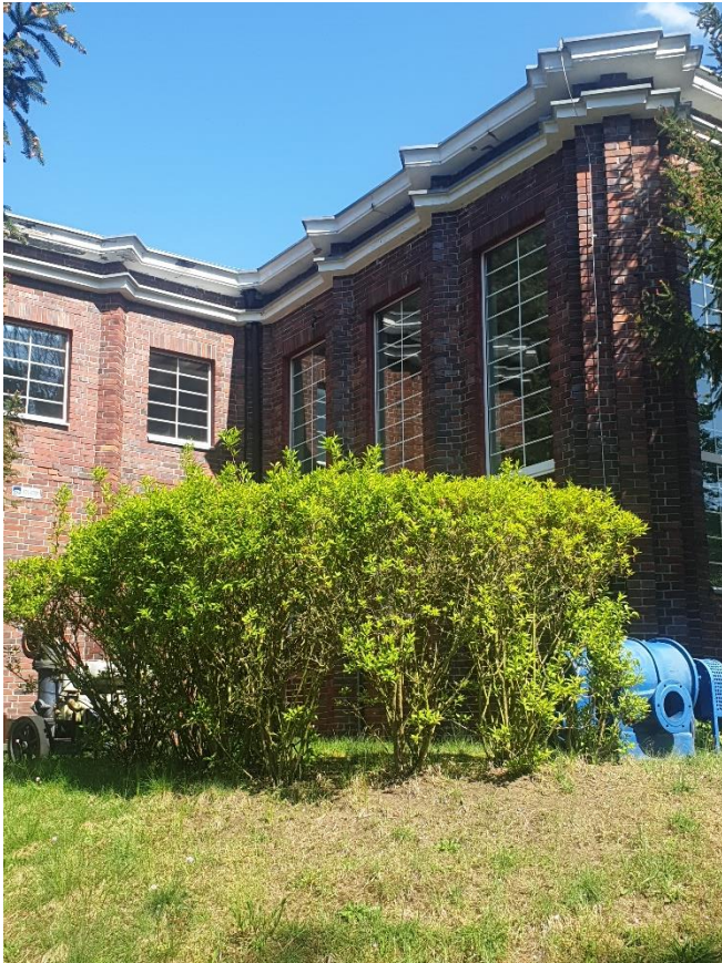
Architektura budynków Zakładu produkcji wody w Pilchowie – zabytek modernizmu berlińskiego z 1928 r, zwracają uwagę pionowe pilastry i gzyms wieńczący. Budynki zaprojektował architekt Maltritz.
